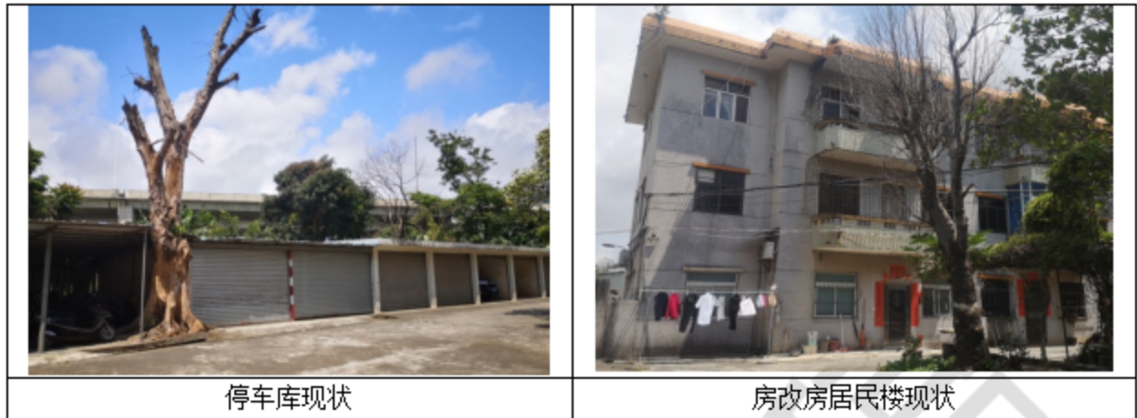
图 3.2-2 洪湾泵站施工场地周边现状照片
