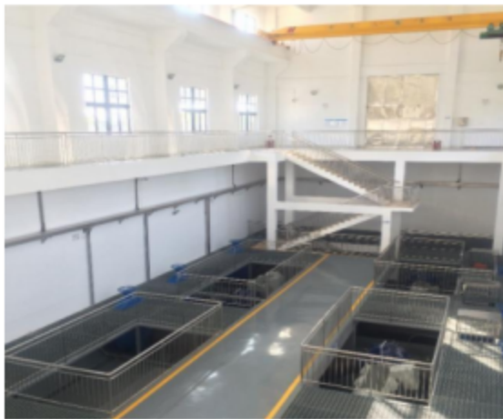
新洪湾泵站泵房图
