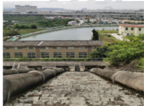
旧洪湾泵站泵房、前池和出水管
